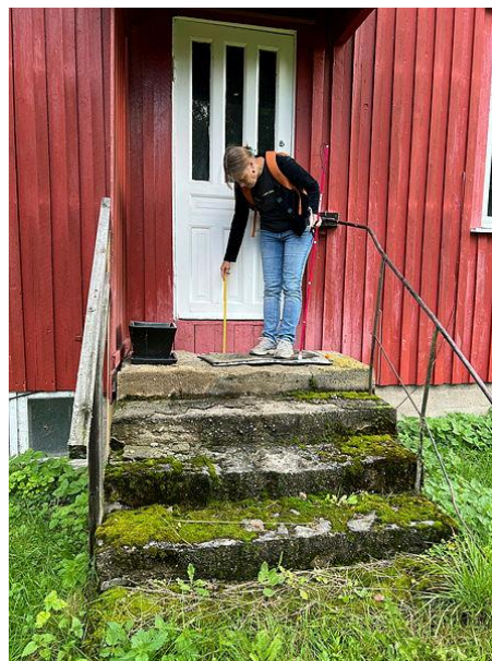
Bilde 4 Inngang Vinkelen (Foto: Akershus fylkeskommune)
