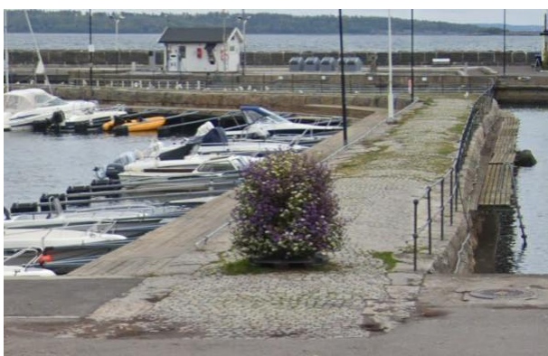
Bilde 25 Broen fra "Pikene på broen" har ujevnt belegg. (Foto: Google maps)
