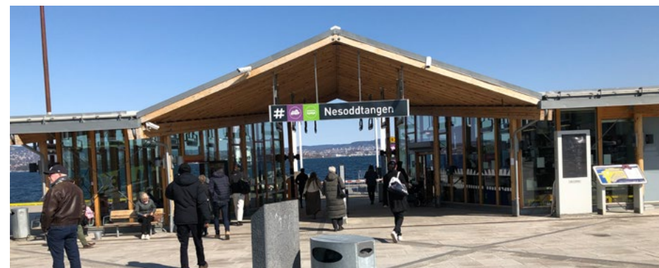
Publikumsbygg (venterom) på fergekai skal ha universell utforming. Nesoddtangen.
