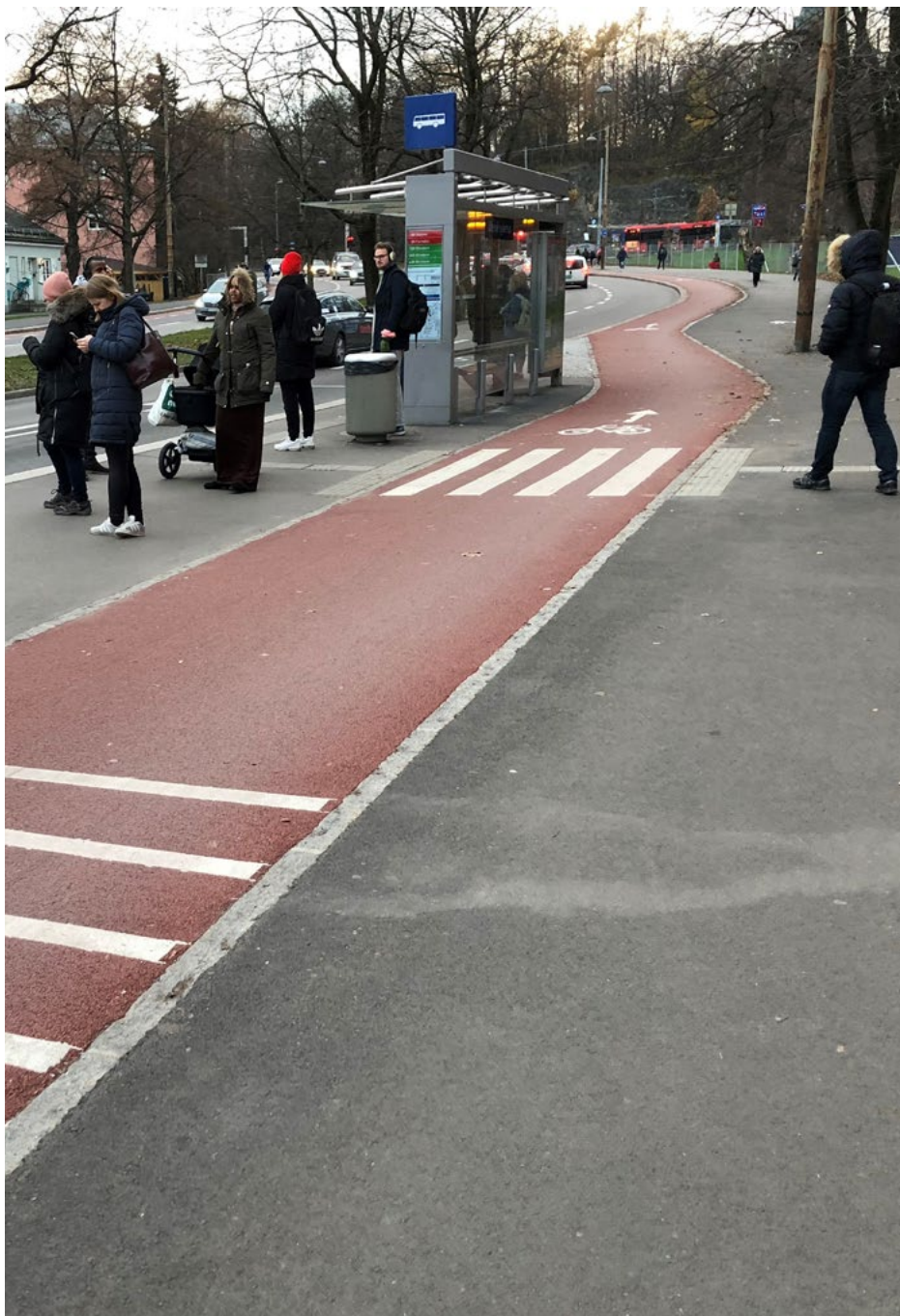
Sykkelfelt og holdeplass ved Ullevål sykehus, Oslo.
