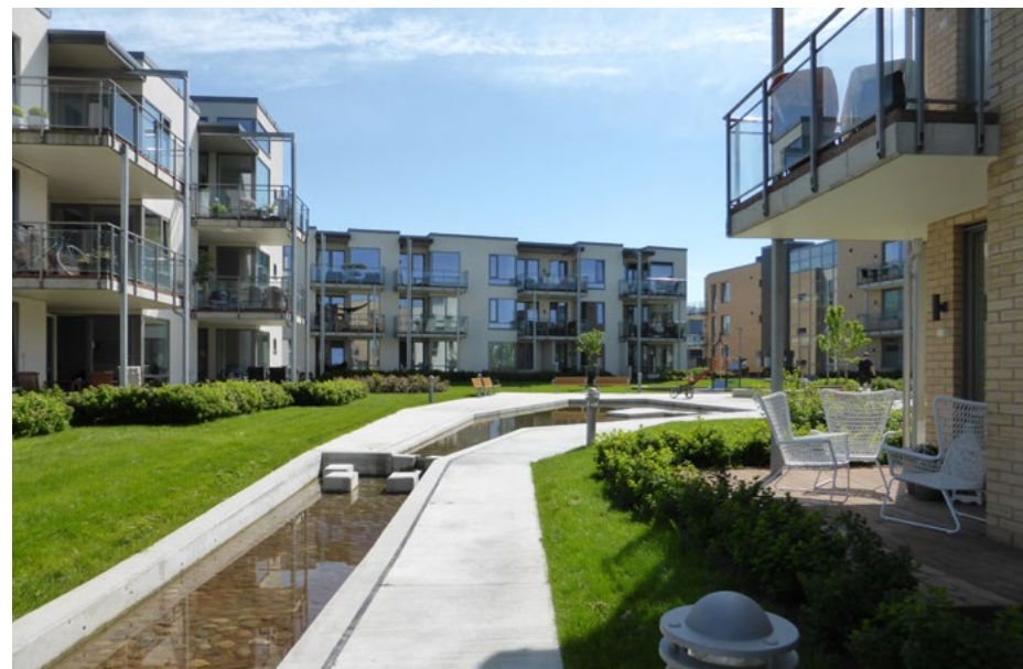
Boliger med krav om heis skal ha uteareal med universell utforming. Grillstadfjæra, Ranheim, Trondheim
